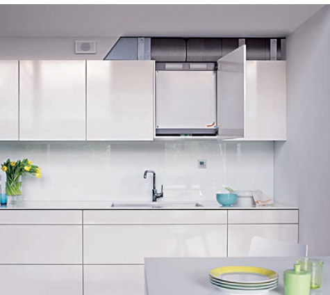
Küchenintegriertes Lüftungsgerät – minimaler Platzbedarf
