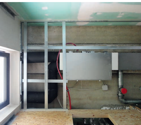
Gerät und Verteilung unter der Decke
