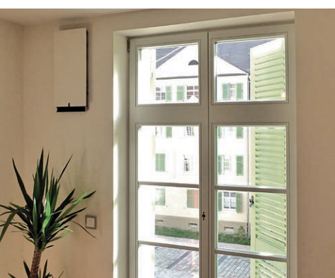
Wandintegriertes Lüftungsgerät
