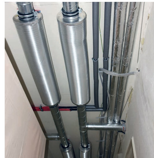
Wickelfalzrohr mit integrierten Schalldämpfern
